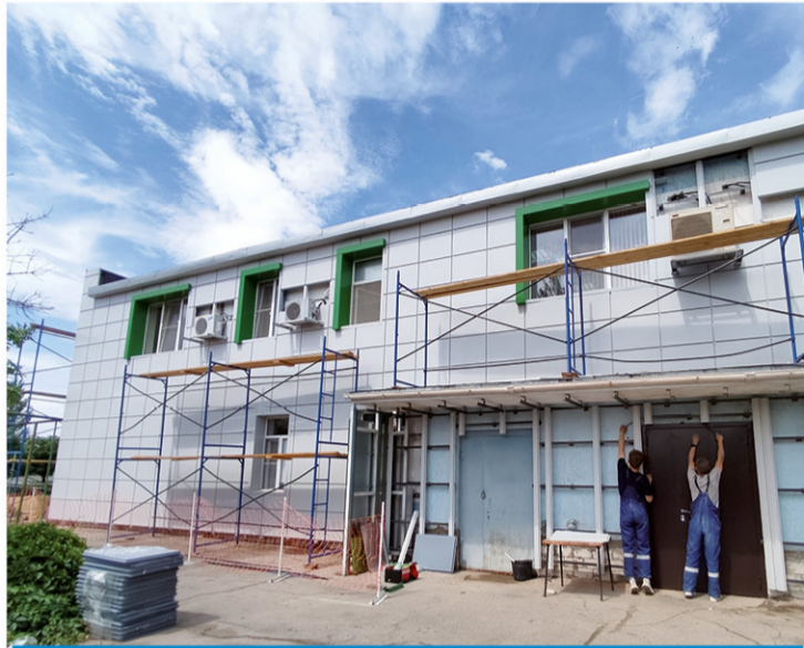
Ведутся строительно-монтажные работы на фасаде здания столовой
