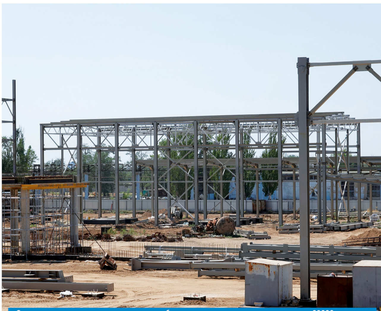
Строительство нового цеха по производству бутилового ксантогената калия мощностью 20000 тонн в год
