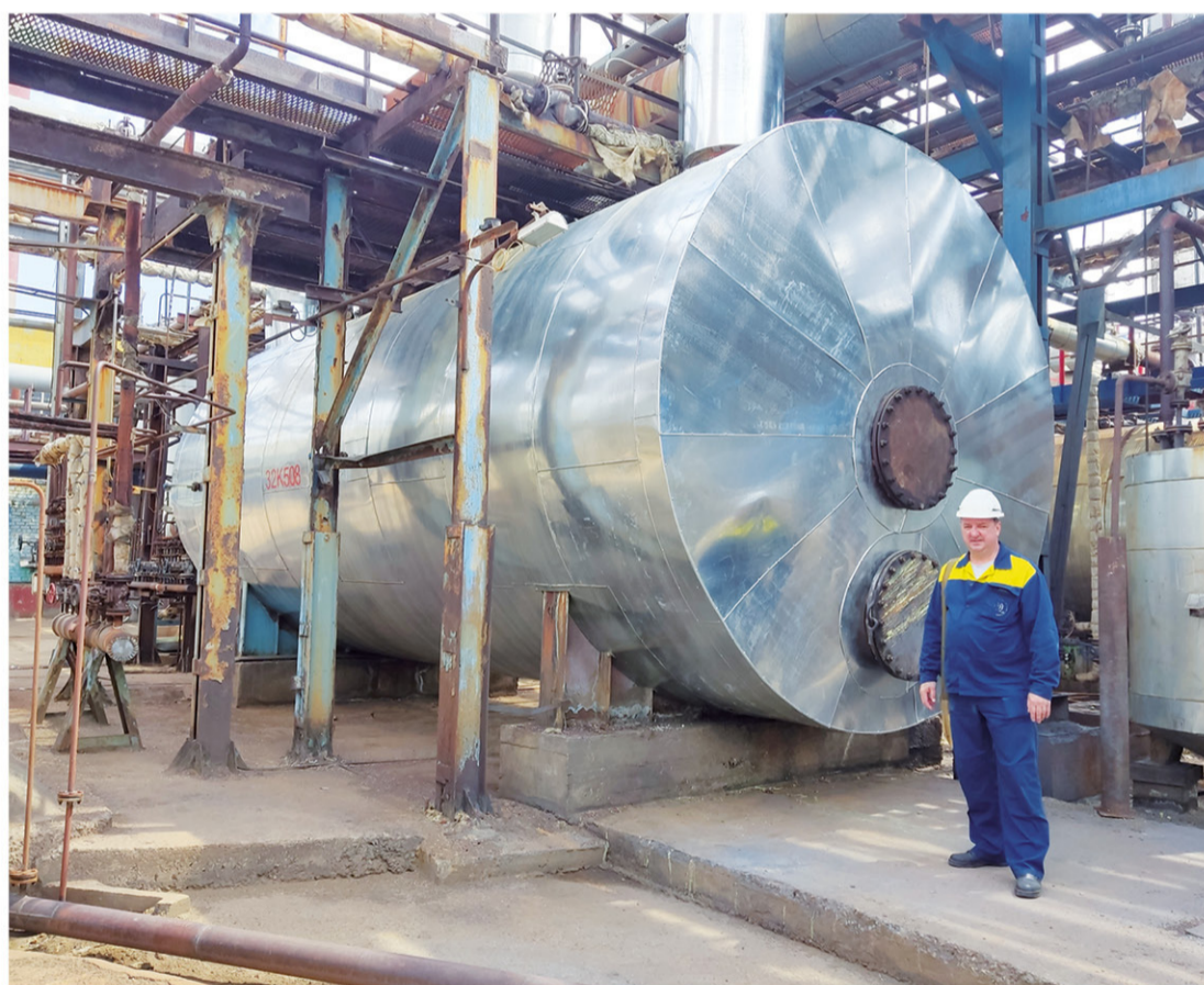
Зам. руководителя службы по ремонту технологического оборудования, Жолобов Александр Анатольевич рядом с конвертером 32K508 после проведения капитального ремонта
