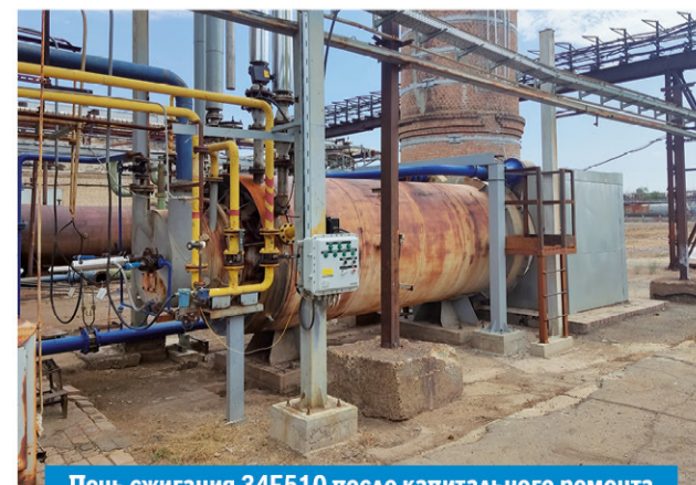
Печь сжигания 34F510 после капитального ремонта
