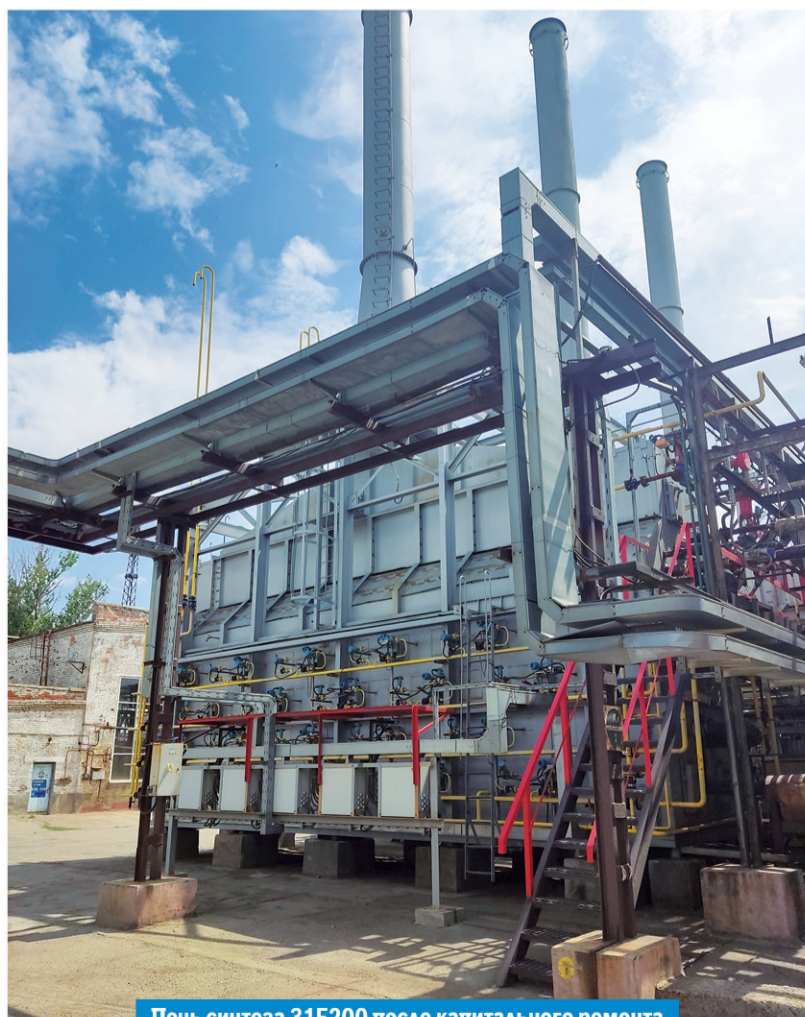
Печь синтеза 31F200 после капитального ремонта
